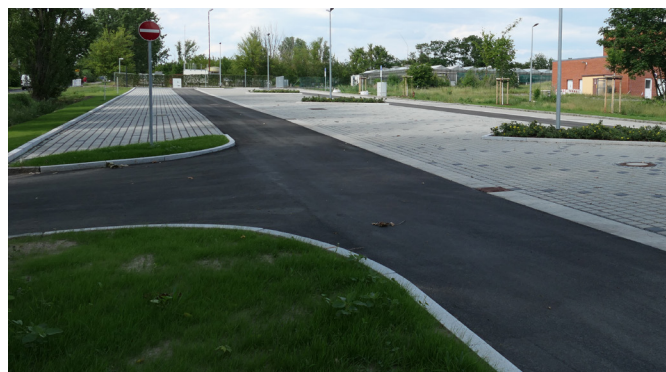
Parkplatz am Haus 5.
