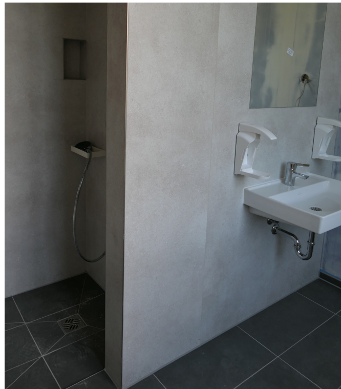
Personalduschen werden aktuell eingerichtet im Haus 10.
