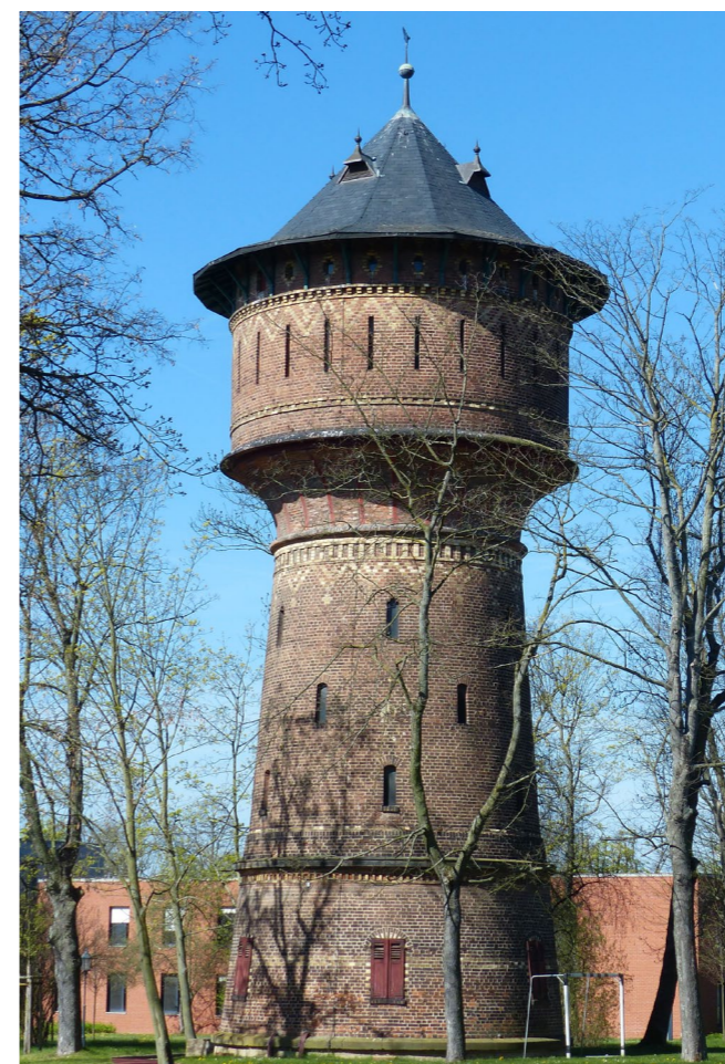
Großes Projekt wird die Sanierung des Wasserturmes. In einen Anbau wird hier dann künftig die Geschichtsgalerie integriert.
